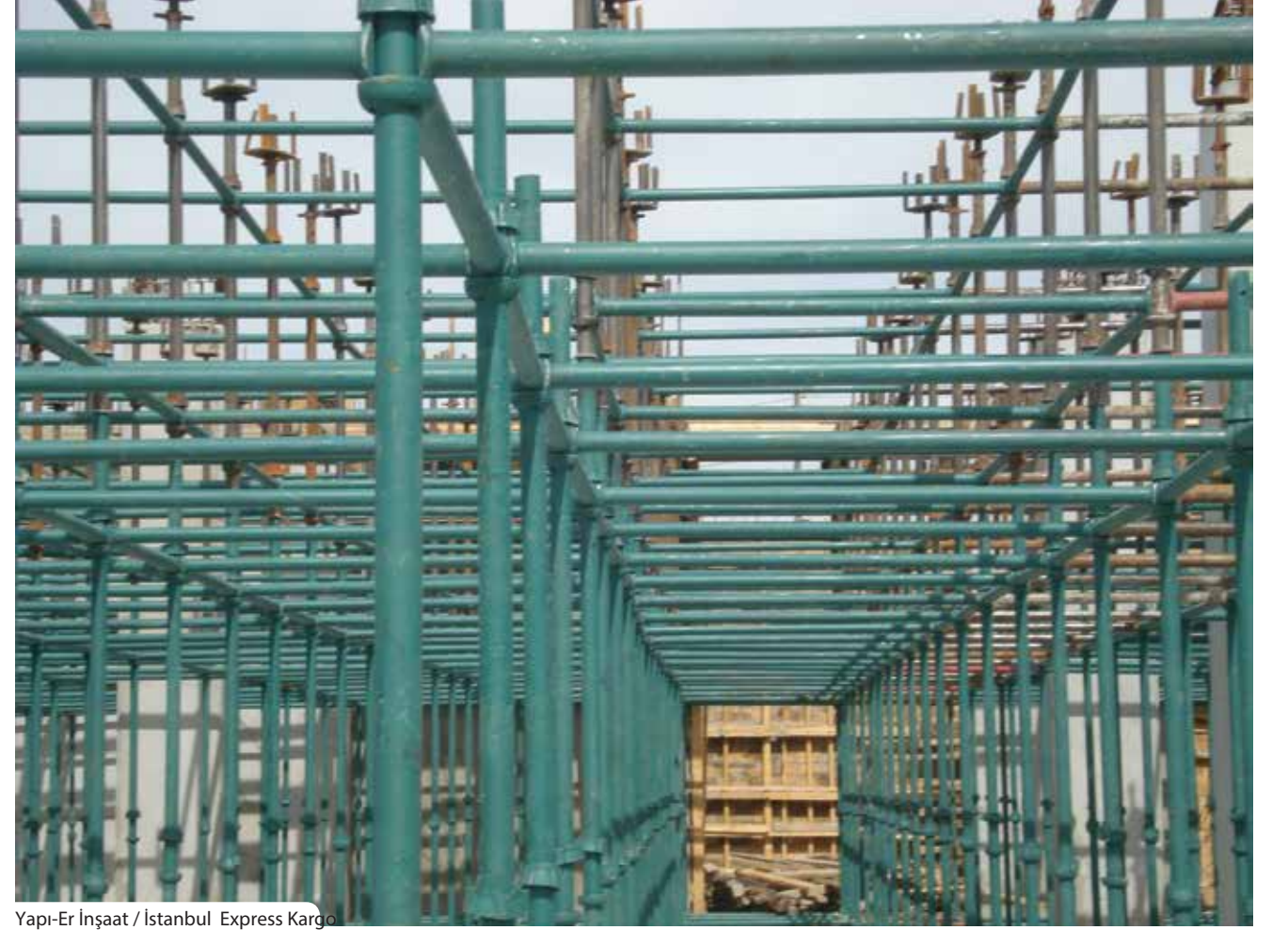
Yapı-Er İnşaat / İstanbul Express Kargo
