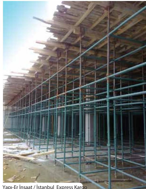
Yapı-Er İnşaat / İstanbul Express Kargo
