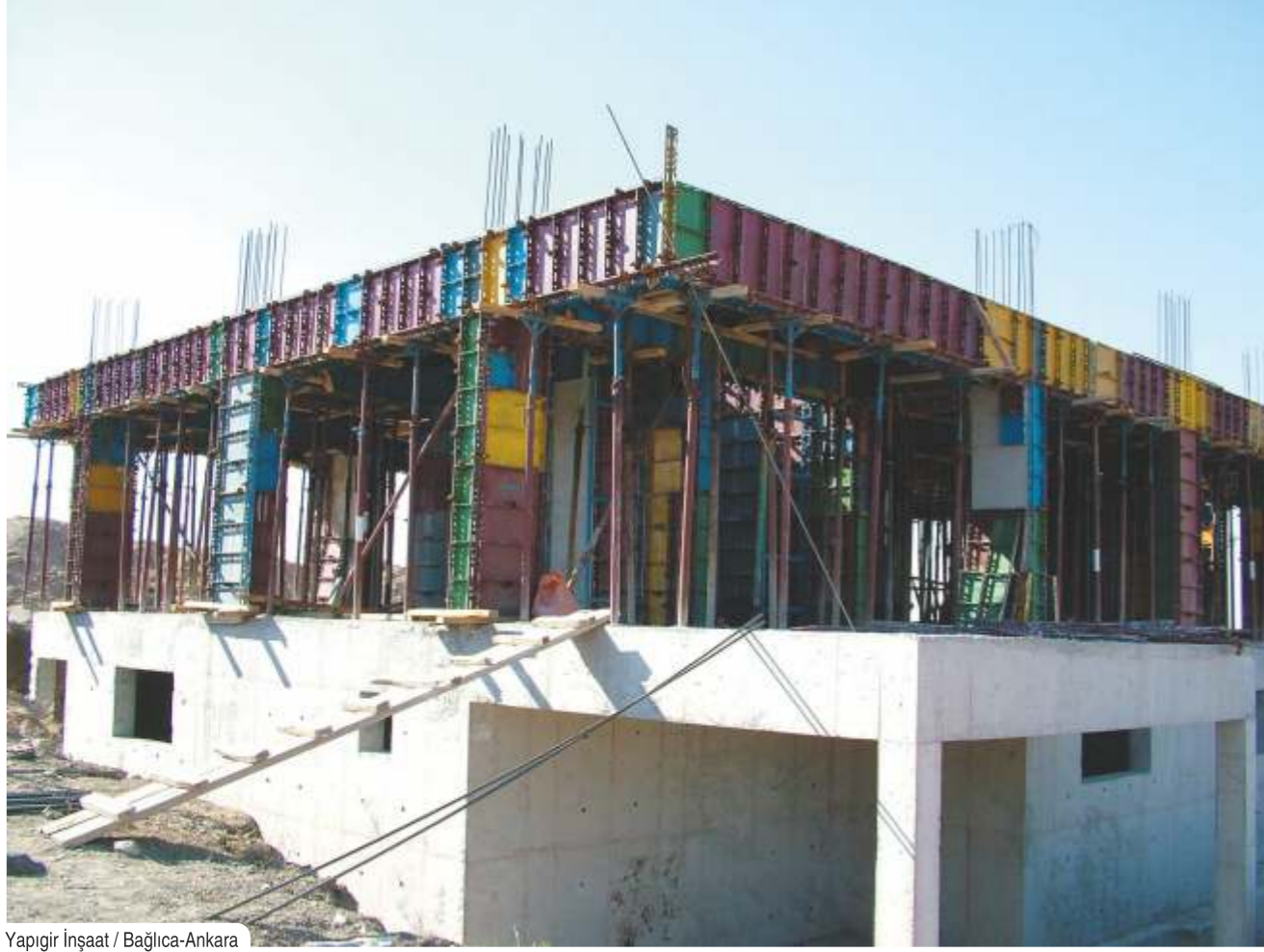
Yapı İnşaat / Bağlıca-Ankara
